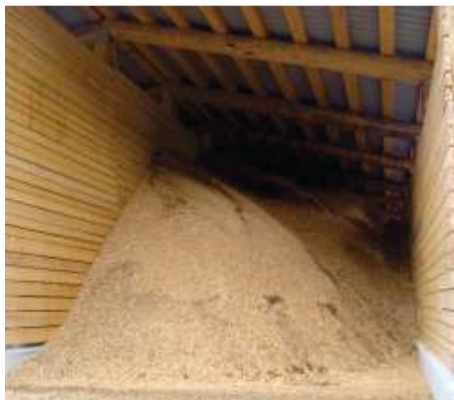
Plateforme de stockage de bois énergie (La Mouille - Jura). Construction en sapin et épicéa de la commune de Morbier.
