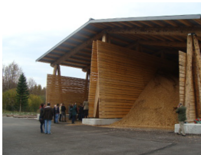
Plateforme bois déchiqueté à la Mouille (39).
